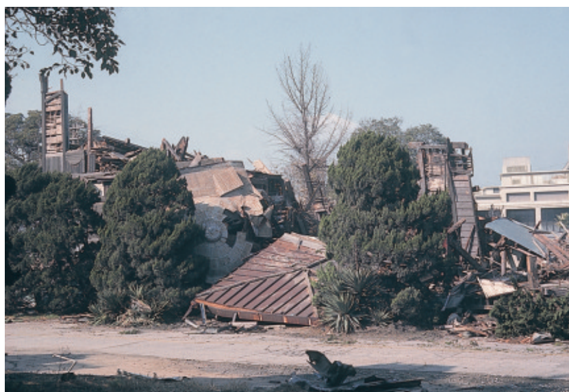
旧・皮膚泌尿器科棟の取りこわし
